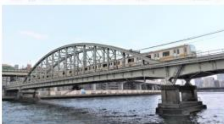
10 総武線隅田川橋梁 1932年竣工/鉄道省 3径間ゲルバー下路式ランガー桁 ※この鉄橋が出来て総武線が初めて隅田川を越えた
