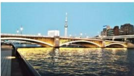
9 蔵前橋 1927年竣工/復興局/旧・富士見の渡し 3径間連続上路式ソリッドリブ2ヒンジアーチ および上路式コンクリート固定アーチ 東京都選定歴史的建造物
