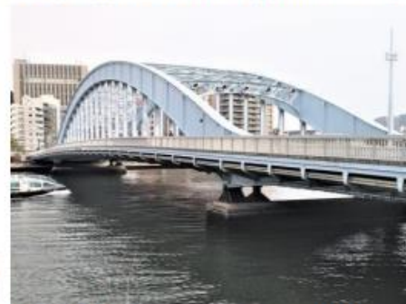
17 永代橋 ★ 初代:元禄11(1698) 1926竣工/復興局/中央:下路式スチールアーチ橋 両側:鋼桁橋/重要文化財 帝都の門として架けられた重厚な橋
