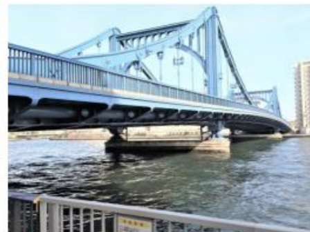
15 清洲橋 ★ 1928竣工/復興局/自碇式鋼鉄製吊橋 旧・中洲の渡し/重要文化財 ドイツのケルンのつり橋(焼失)をモデルに作られた。
