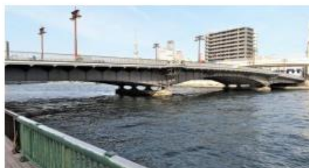
12 両国橋 ★ 初代:寛文元(1661) 1932年竣工/東京市/3径間ゲルバー式鋼板桁橋 東京都選定歴史的建造物
