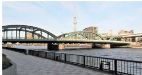
8 厩橋 ★ 初代:明治7(1874) 1929年竣工/東京市/旧・御厩の渡し 3径間下路式タイドアーチ橋 東京都選定歴史的建造物
