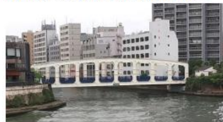
16 豊海橋 ★ 初代:元禄11(1698) 1927年竣工/復興局/下路式フィーレンディール橋 中央区民文化財/福山雅治「いつかまた逢える」ロケ地 江戸期は、永代橋が上に在り、赤穂浪士も渡った橋
