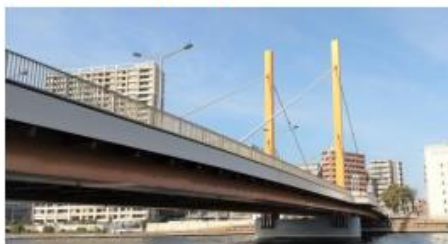
13 新大橋 初代:元禄6(1693) 1977年竣工/東京都/2径間連続斜張橋 キムタクと山口智子主演の「ロンパケ」の舞台 江戸期に架橋、明治期に鉄橋に架け替えられ 関東大震災、東京大空襲の難を逃れたが、 経年劣化のため、現橋に架け替えられた。 旧橋は明治村に部分保存されている。
